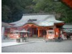
平入拝殿（入母屋造） 熊野那智大社 （和歌山県那智勝浦町）
