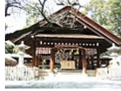
妻入拝殿（切妻造） 大鳥大社 （大阪府堺市）
