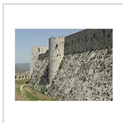
側防塔と幕壁の傾斜面
