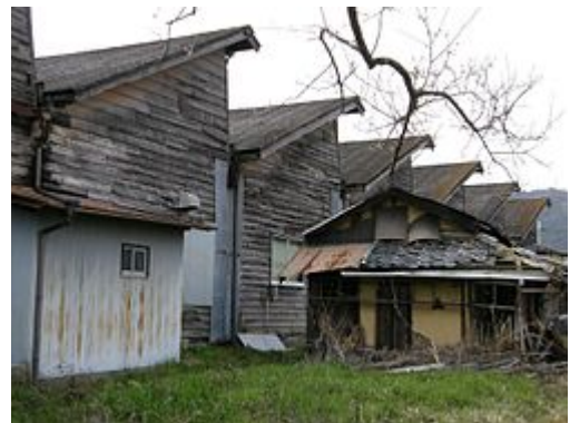
神結酒造工場の鋸屋根（兵庫県加東市下滝野）
