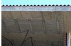
鉄筋コンクリートの屋根スラブ
