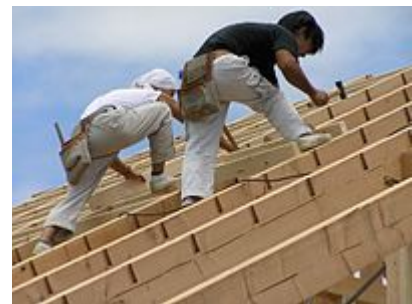
造作中の民家の屋根。垂木構造がよく分かる。
