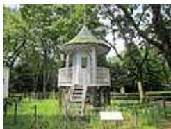
上野消防署（旧・下谷消防署）望楼上部
