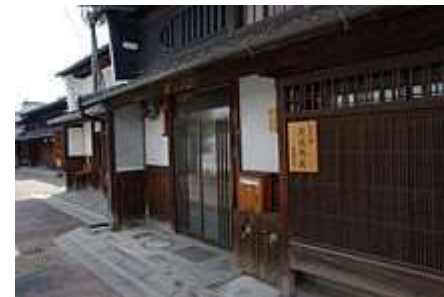
芝新屋町、寧屋工房付近（南方向を望む）
